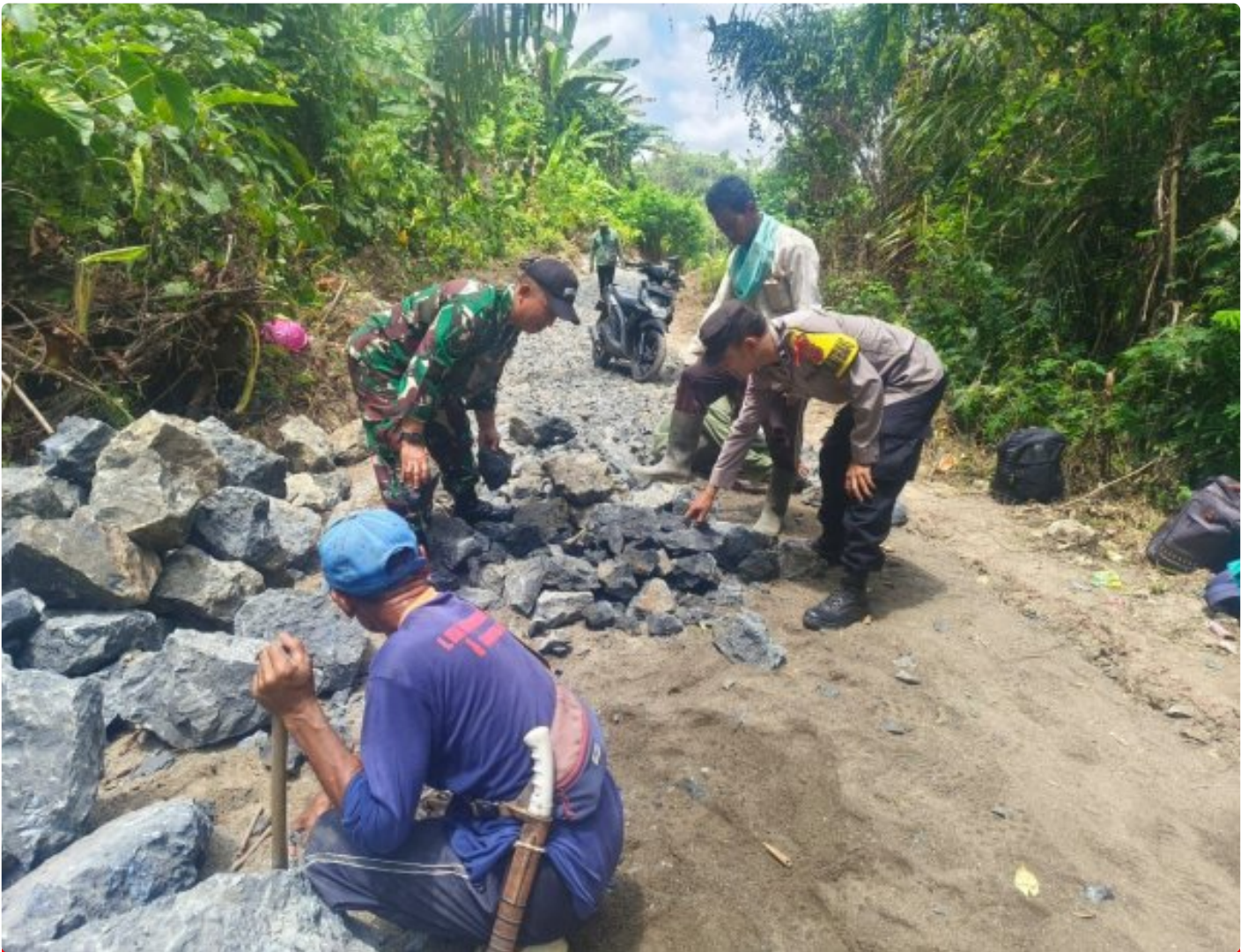
Sinergitas TNI Polri di Sagaranten, Gotong royong Bantu Pembangunan Jalan warganya
