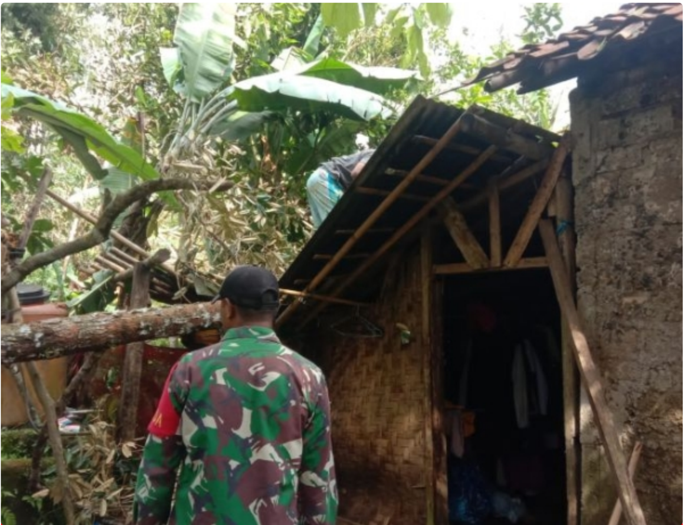
Koramil Cikidang Bantu Perbaiki Rumah Warga yang di Sapu Puting Beliung
