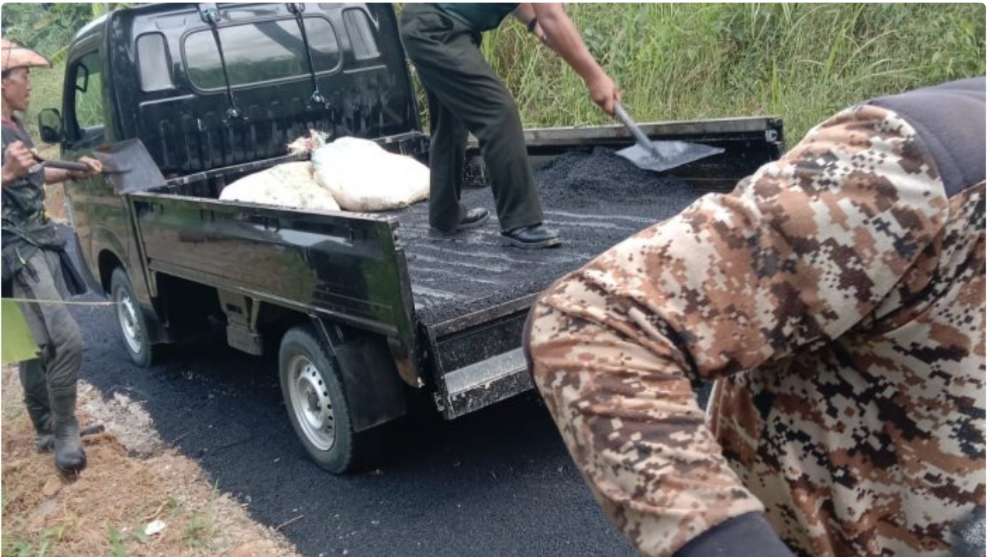
Koramil 0622-04/Cikidang Monitor Pembangunan Jalan ADD Sepanjang 400 M
